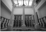
Pozlama değişim miktarı: 0 EV
