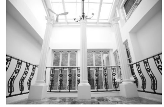
Pozlamanın değiştirilmesi: +1 EV
